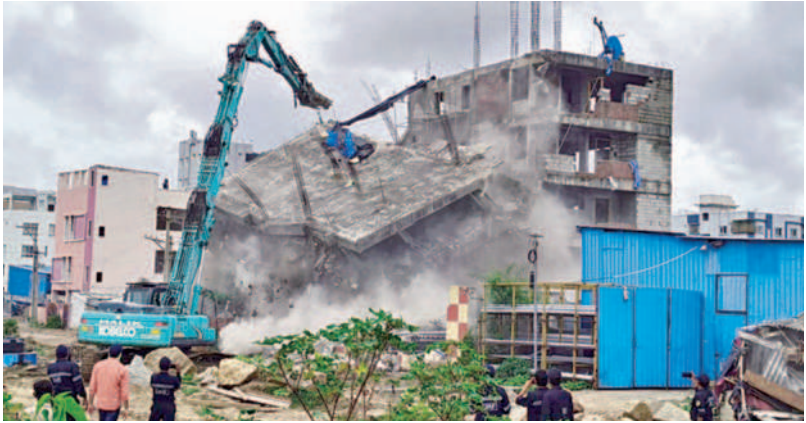
ఆదివారం మాదాపూర్ లో అక్రమ నిర్మాణాలను కూల్చివేస్తున్న హైద్రా
